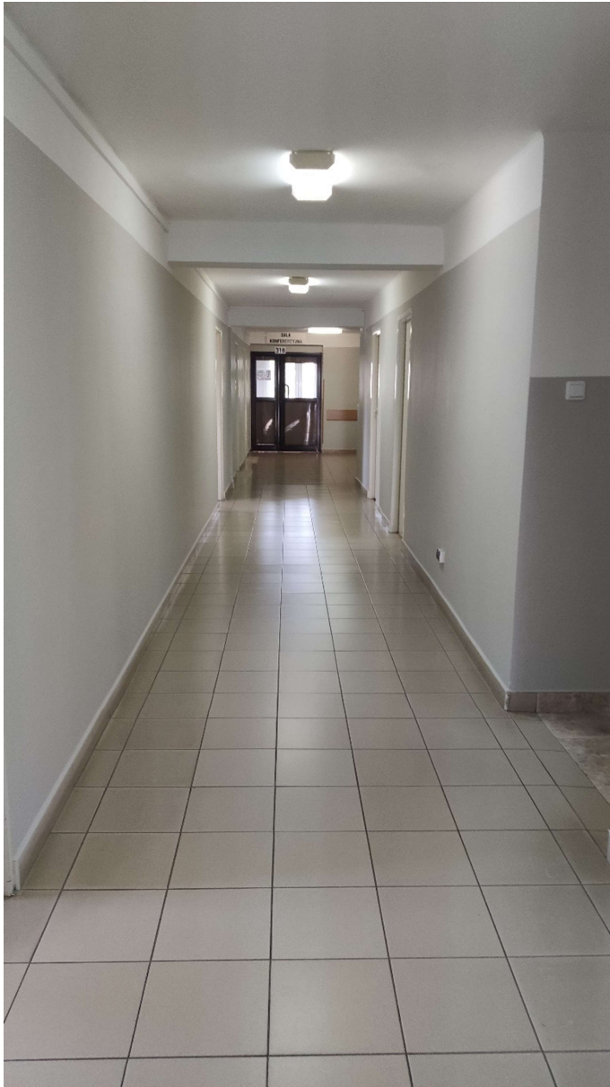
Zdjęcie nr 17 – jeden z korytarzy w budynku Urzędu
