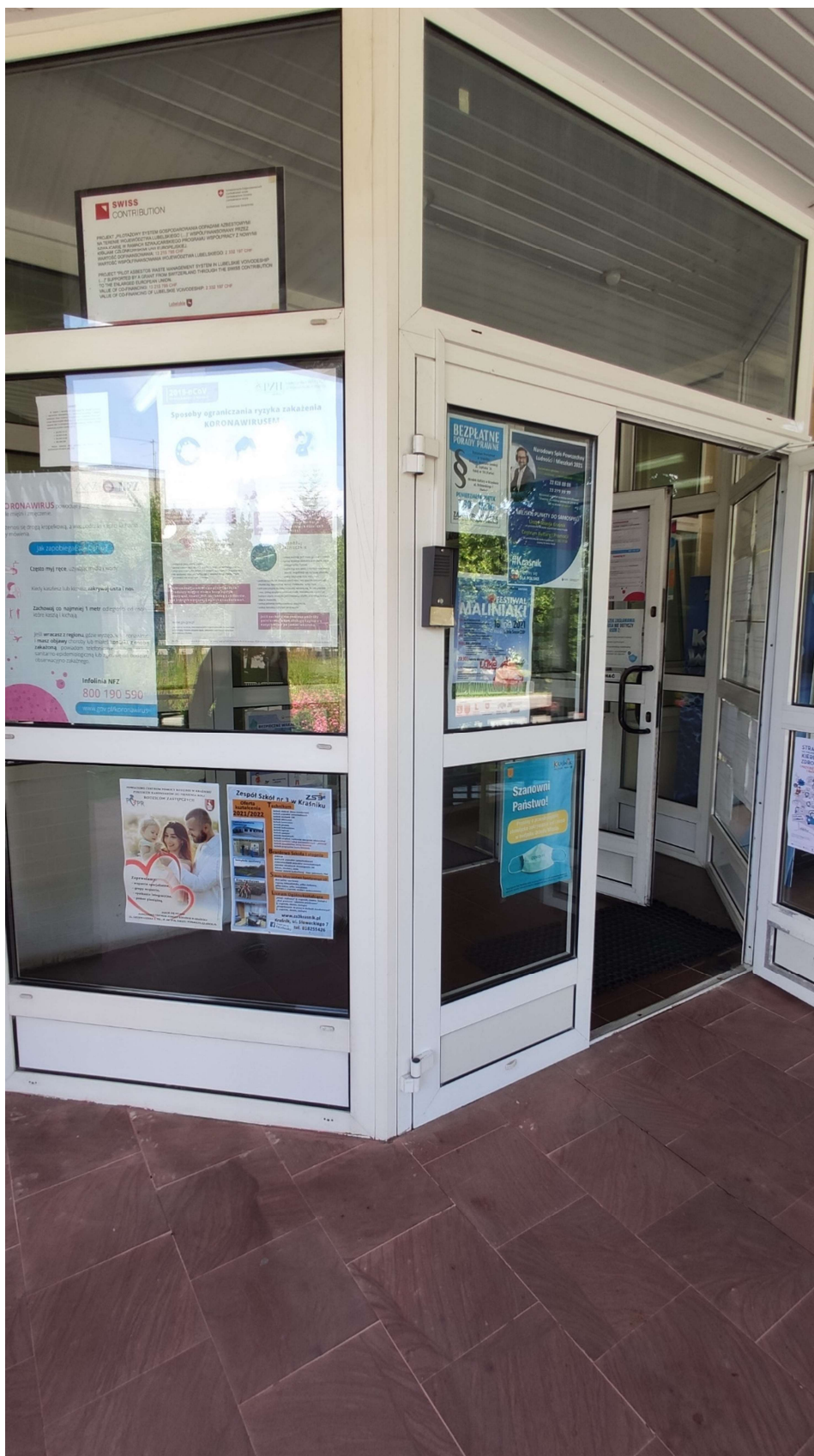
Zdjęcie nr 5 – wejście do budynku Urzędu.
