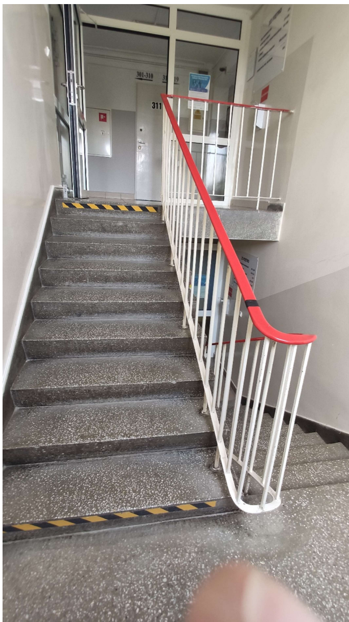
Zdjęcie nr 16 – schody w budynku Urzędu
