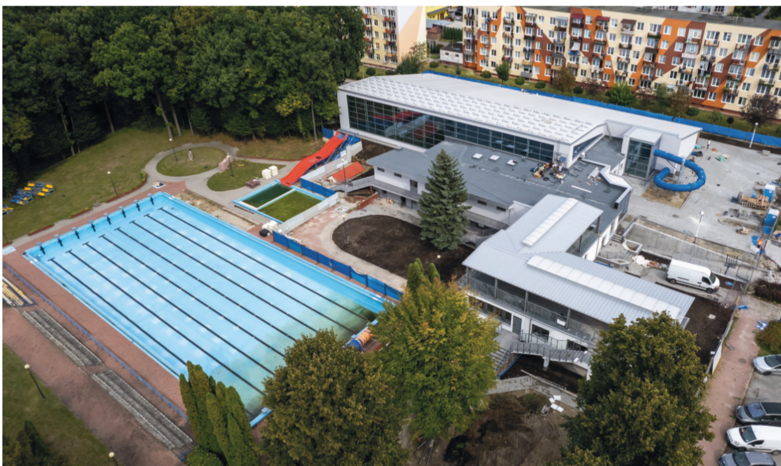
Gruntowna modernizacja kraśnickiego basenu zbliża się ku końcowi.
