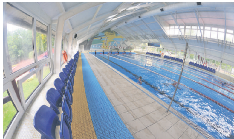
■ Ostatnie - „kosmetyczne” - prace przy basenie przeprowadzono w 2012 roku.
