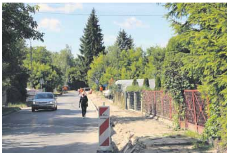
■ Budowa nowego chodnika przy ul. Podleskiej.
