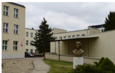
Sala gimnastyczna dla przedszkolaków
