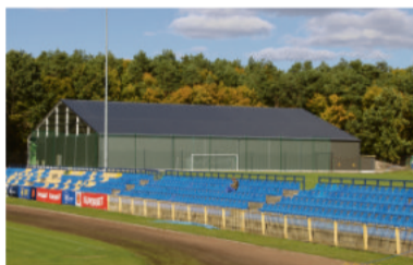
Hala tenisowa prawie gotowa
