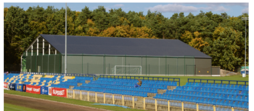
Na starych kortach ziemnych MOSiR stoi już hala tenisowa, rozpoczęły się także prace związane z zadaszeniem trybun.
