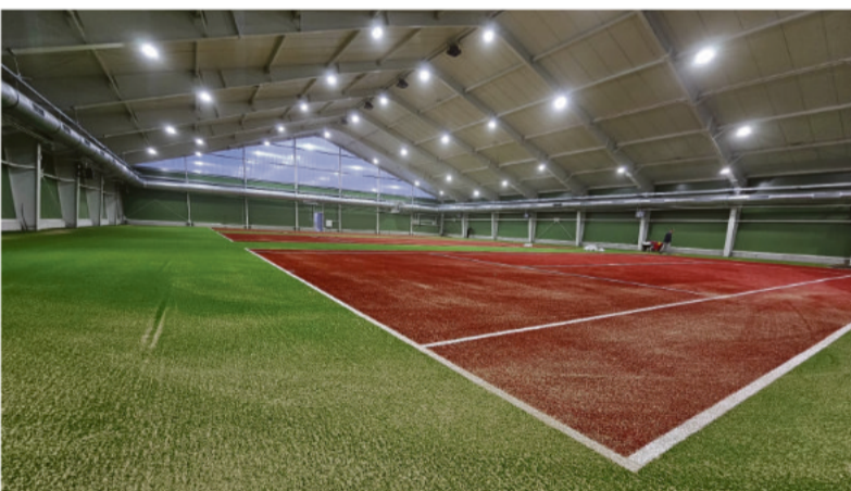
W miejscu dawnych ziemnych kortów na MOSiR powstała nowoczesna hala tenisowa.
